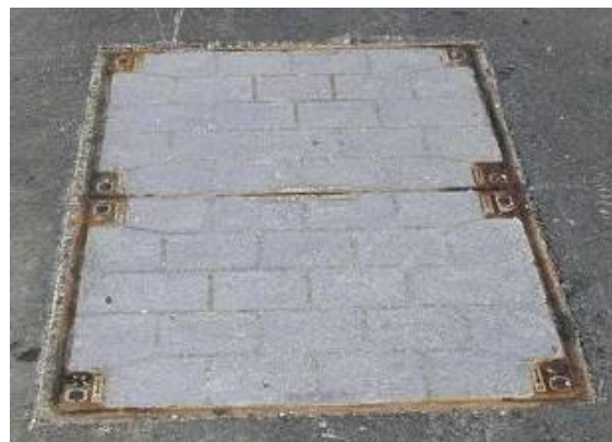
Abbildung 6 Kabelkanalisation: Einstiegschacht Ansicht oben
