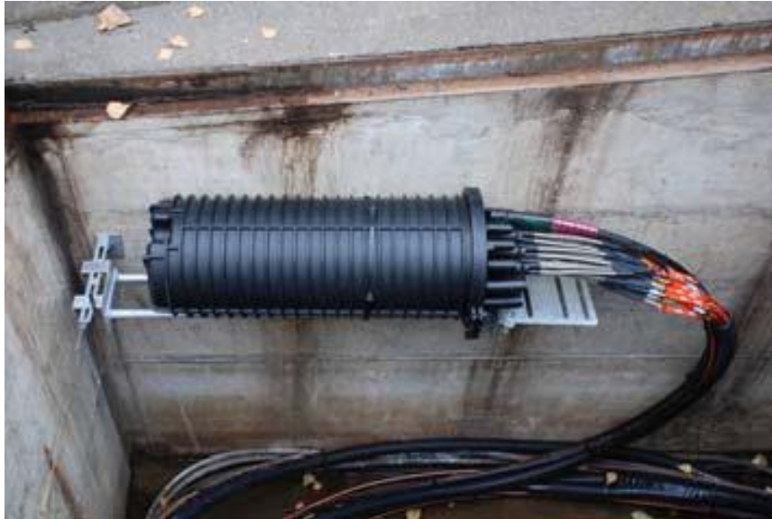
Abbildung 21 Kabelkanalisation: Platzierung Spleissmuffe
